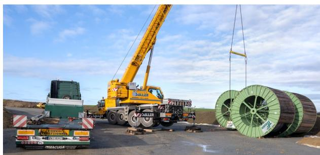
Abbildung 6: Auf eine Kabelspule passt ein Kabelstück mit rund einem Kilometer Länge. Das Foto zeigt die Kabelanlieferung auf einer ähnlichen Baustelle in Niederbayern aus dem Jahr 2022.
