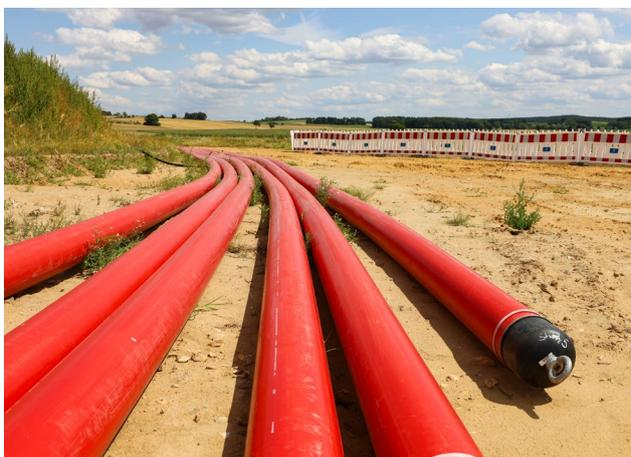
Abbildung 3: Die Rohre liegen für das Verlegen mit dem Pflug oder im offenen Graben bereit.
