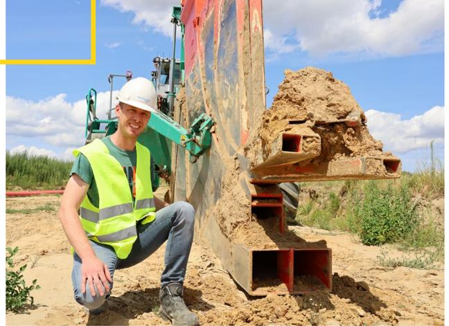
Abbildung 1: Das Pflugschwert neben Bauleiter Bernd Igelbüscher verschwindet komplett unter der Erde und bringt die Leerrohre in den Boden.
